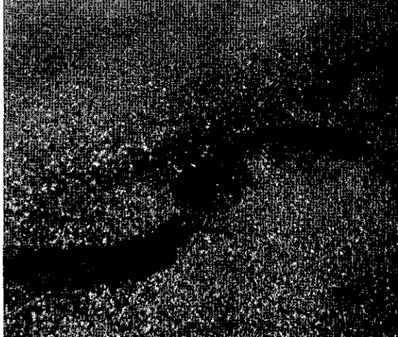
Scheurvorming in een asfaltbekleding
